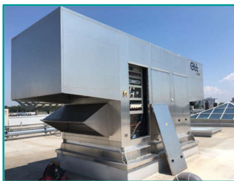
Rooftop sur bâtiment commercial
