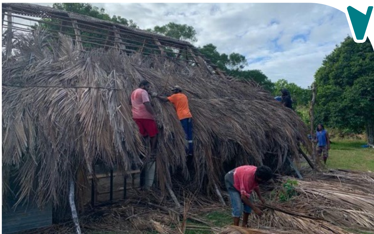
Construction communautaire et familiale d'une case à Ouvéa.
