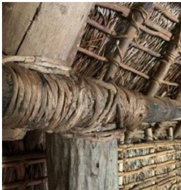
Attaches, liens, tissage, enroulages, les processus de construction de la case symbolisent les processus de construction de la cohésion sociale du clan, des liens humains. Ci-dessous, détails d'attaches de cases à Lifou et Ouvéa.
