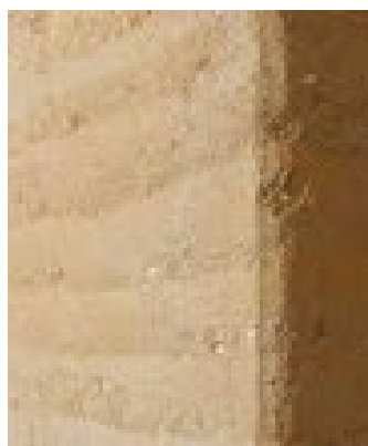
Isolant à base de bourre de coco, fibre de pandanus tressée, murs en béton de terre, poteau en bois de cocotier.
