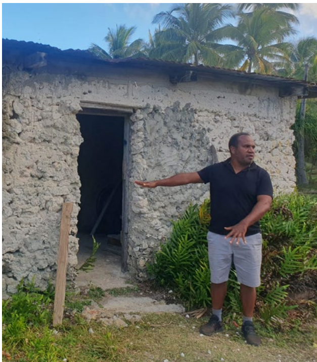
À Lifou, visite d'une maison en chaux, procédé de construction que les habitants souhaitent réintroduire.
