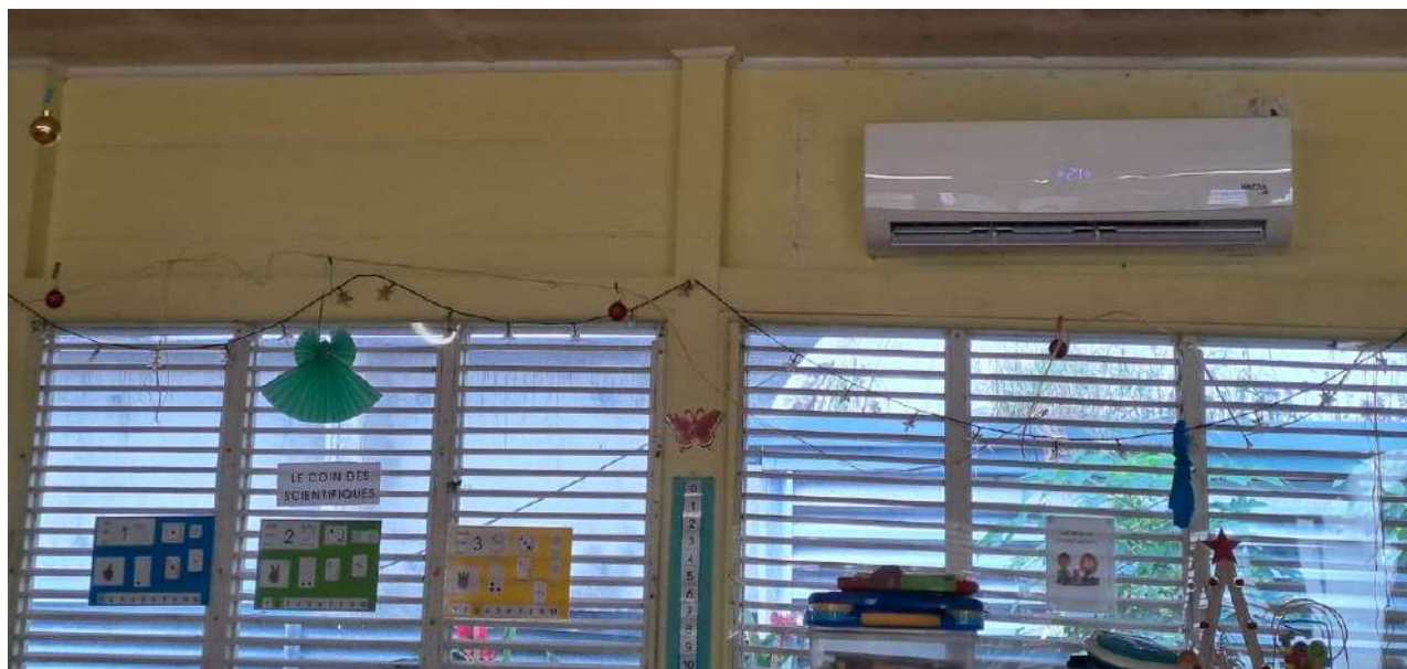
Climatisation d'une salle aux menuiseries non étanches
