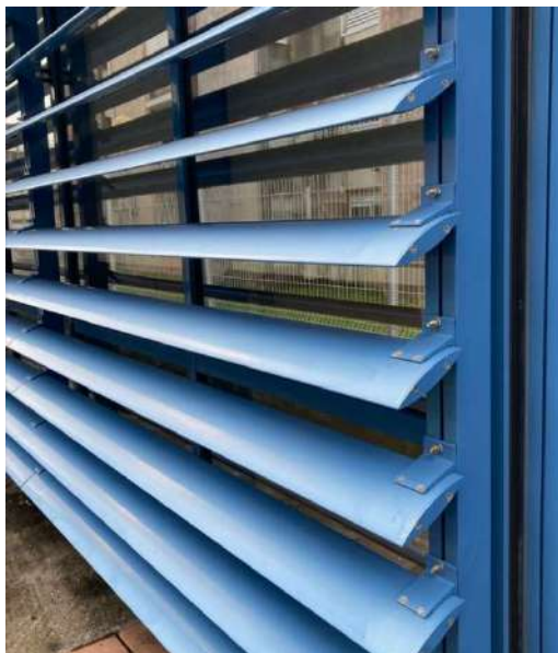
Protection solaire recouvrante
