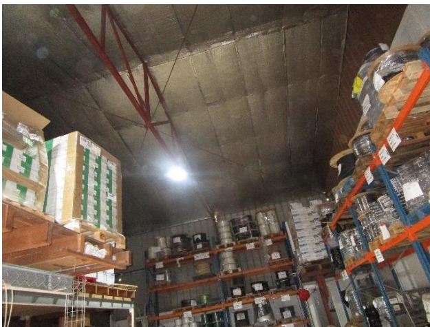
Photo 8 - Isolant mince réfléchissant – IMR
