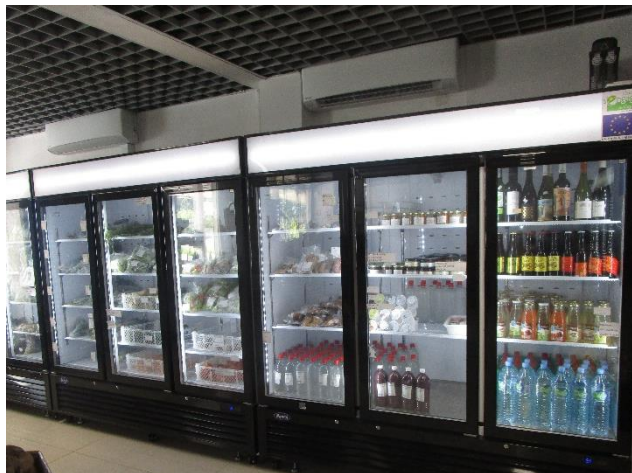
Photo 63 - Climatiseurs et meuble de froid positif fermé
