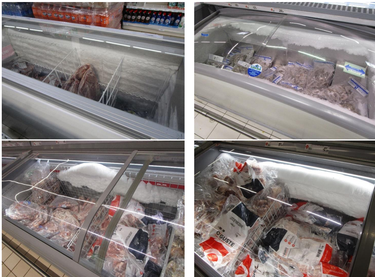
Photo 69 - Exemples de meubles de froid négatif fortement givrés
