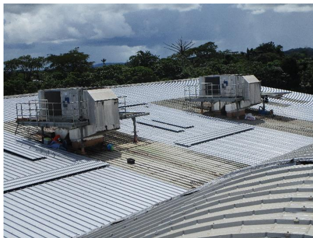
Photo 21 - groupe de production de systèmes roof-top
