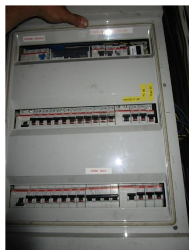
Photo 3 - Synoptique très succinct et par ailleurs erroné sur tableau électrique
