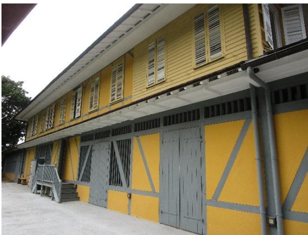
Photo 12 - Parois en parpaings (RdC) et bardage bois + Fermacell (étage)
