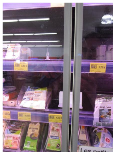
Photo 70 - Exemples de meubles de froid positif avec un jour important entre les portes
