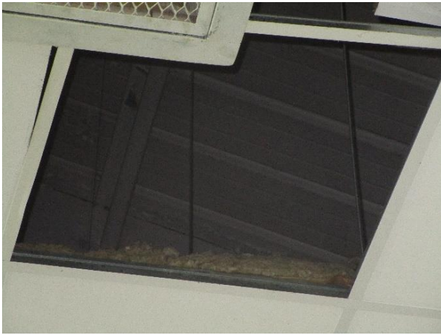
Photo 6 - Isolation en combles
