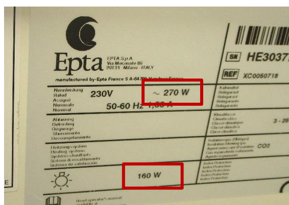
Photo 65 - Puissance du meuble : 270 W ; Puissance de l'éclairage : 160 W
