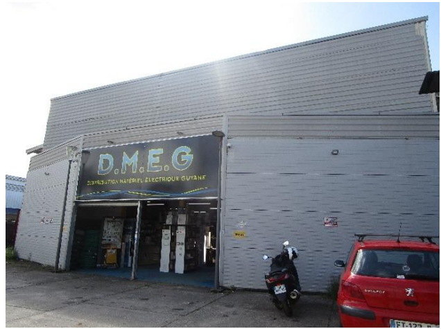
Photo 11 - Panneau sandwich en tôle isolé
