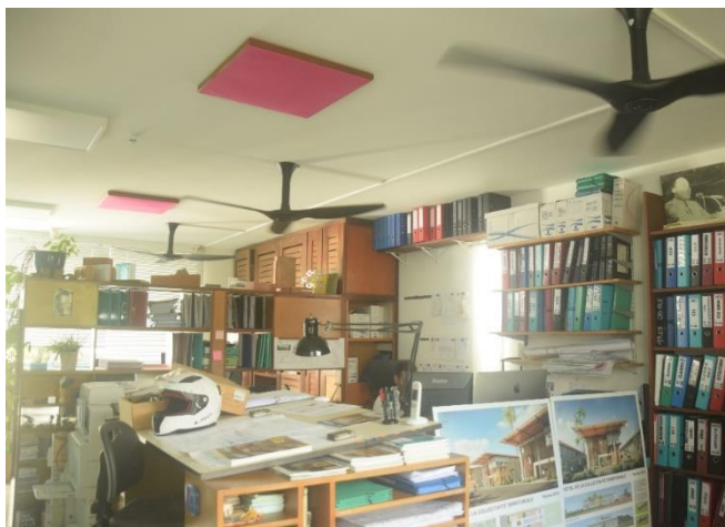
Photo 61 - Open-space du bâtiment 6 avec 3 brasseurs d'air en courant continu et climatisation (non-visible sur l'image)
