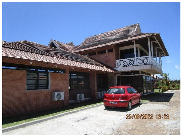
Photo 13 - Murs parpaings + parement brique
