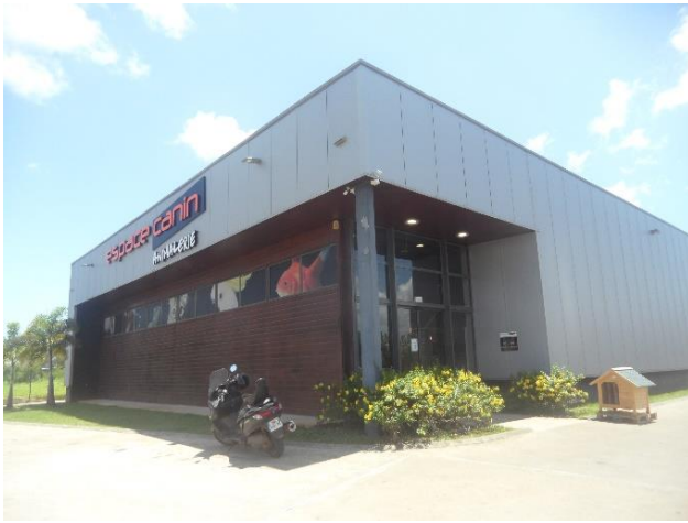
Photo 10 - Bardage panneau Promistyl en laine de roche
