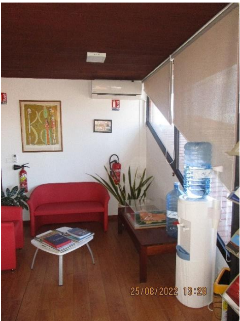
Photo 42 - Fontaine à eau
