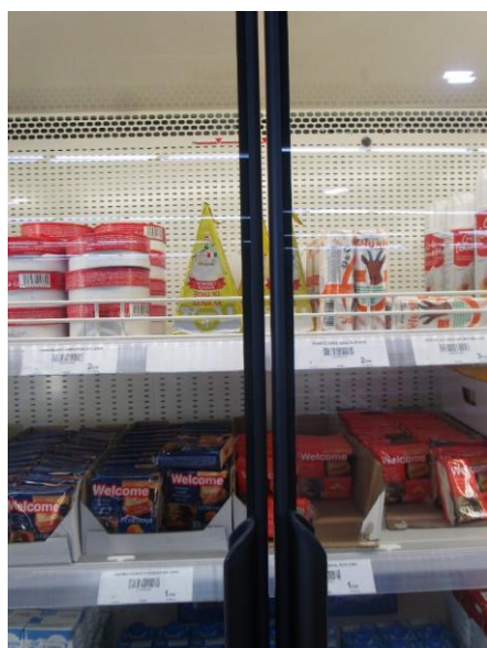
Photo 70 - Exemples de meubles de froid positif avec un jour important entre les portes
