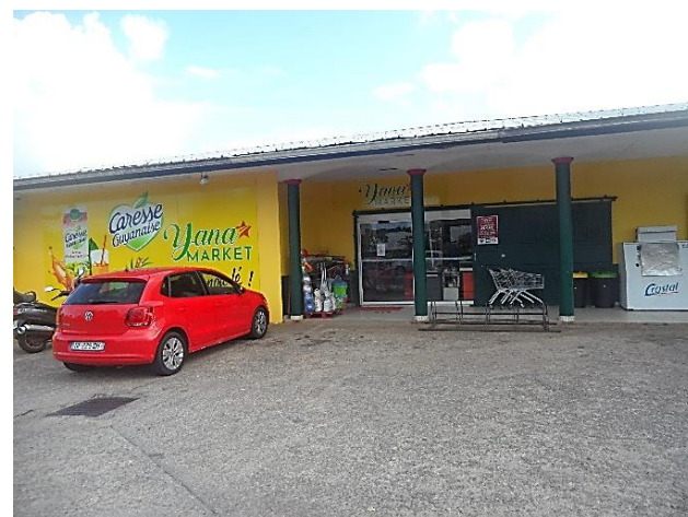
Photo 19 - Pas d'autre ouvrant que la vitrine d'entrée
