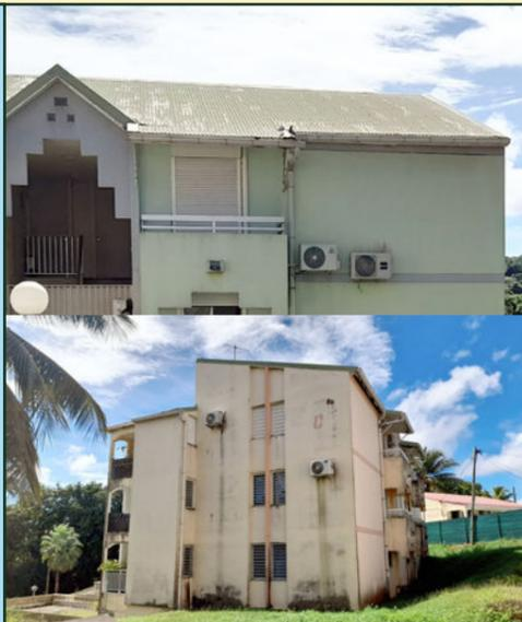
La toiture est généralement réalisée en charpente bois traditionnelle avec une couverture en tôle ondulée. Un plancher sépare souvent les combles de la toiture, ce qui facilite son isolation en combles perdus.
