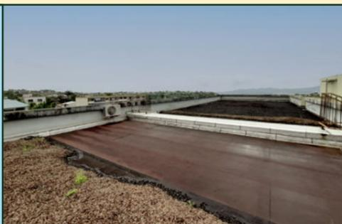
Le système d'étanchéité est souvent une couche bitumineuse protégée par une couche de gravillons sur toute ou partie de sa surface.
