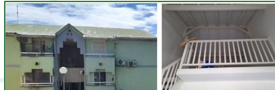
↑ Toitures tôles non isolées
