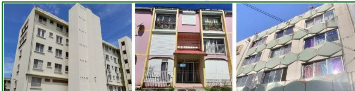
↑ Défauts de protection solaire
