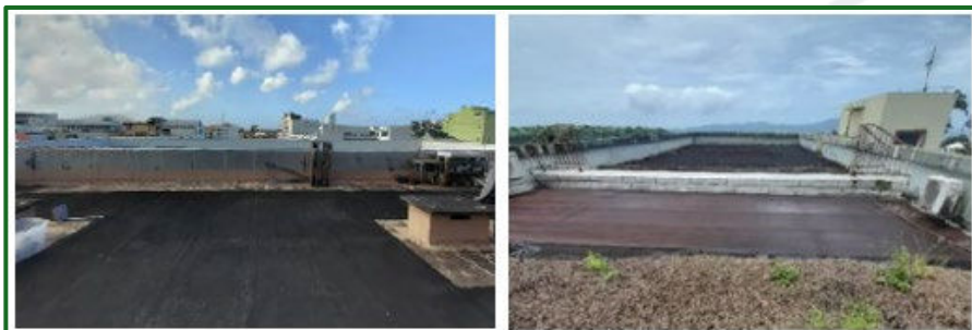
↑ Toitures terrasses sombres non isolées
