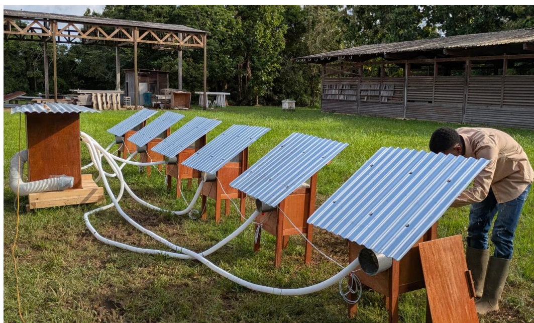
Figure 6 – Dispositif de terrain complet assemblé, avec les 6 prototypes d'essai et la station de climatisation centrale. Les prototypes sont alignés selon l'axe N/S et les toitures sont inclinées face à l'est. Des systèmes de protection imperméables (tubes PVC gris fermés avec du plexiglass) permettent d'assurer le système électrique face aux intempéries et notamment aux pluies fortes.
