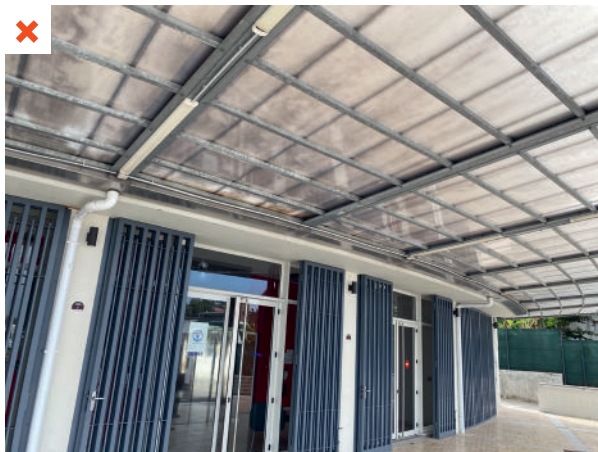
L'auvent, servant à protéger de la pluie en conservant un apport de lumière, est encrassé et ne laisse pas entrer la lumière dans les bureaux. ©AQC
