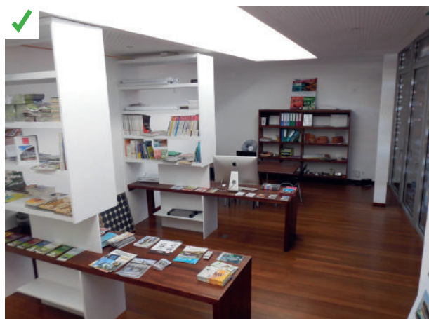
La présence d'un shed en plafond permet un éclairage naturel indirect. ©AQC
