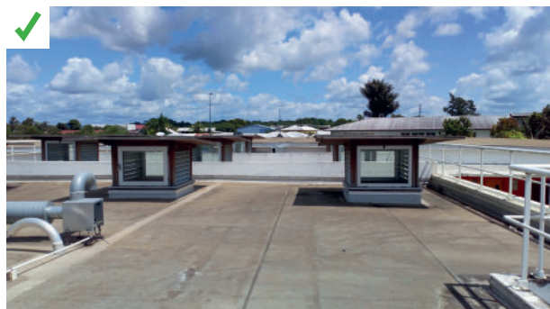
Les vitrages du lanterneau en toiture, installés au nord et au sud, ne sont pas exposés à l'ensoleillement direct. ©AQC
