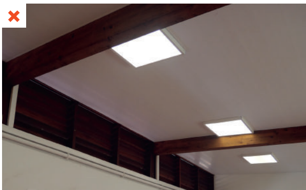
Les dalles lumineuses sont commandées par des détecteurs de présence. L'enseignant n'a pas de contrôle pour allumer ou éteindre en fonction des activités (temps calme, vidéo projection, etc.). ©AQC
