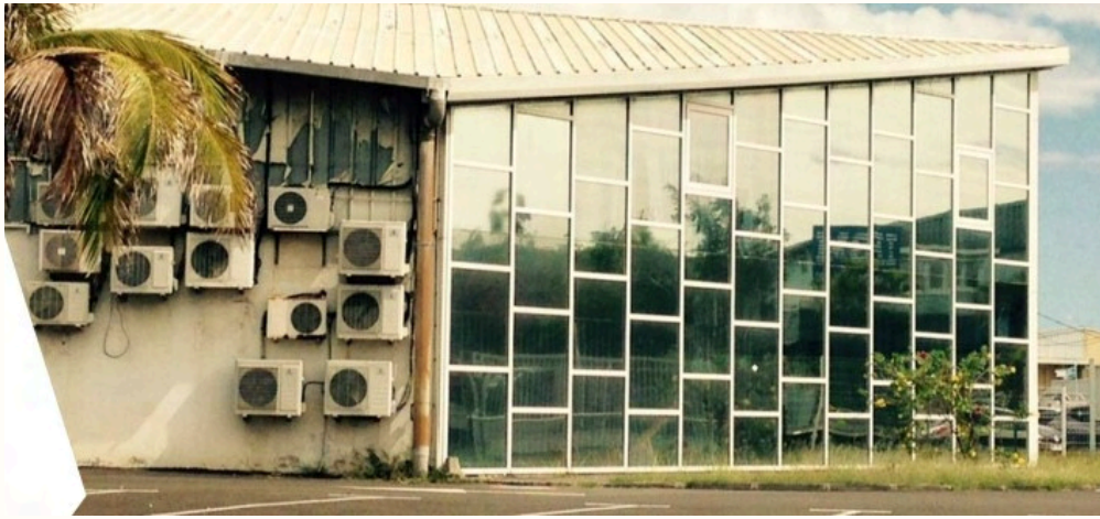
Mur rideau et mur de climatiseurs (Immeuble Romarin, Guadeloupe)
