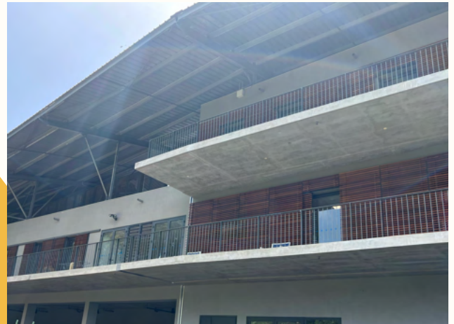
Reconstruction du Centre Hospitalier L.D Beauperthuy à Pointe-Noire - Guadeloupe - Architectes : SCAU architectes et Magma architectures Photo : Laurent Darvot
