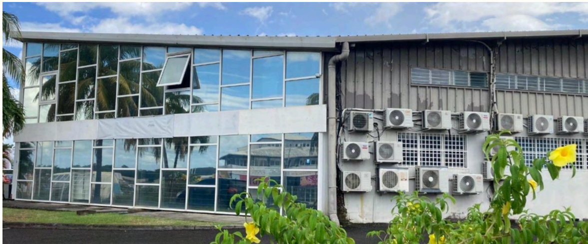
Bâtiment annexe du Conseil Départemental - Guadeloupe - Photo : L. DARVIOT
