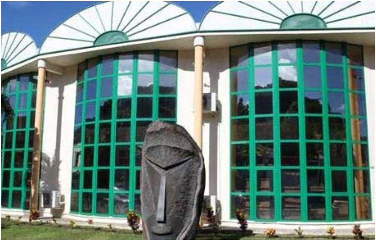
Bibliothèque municipale de Deshaies ; Des travaux sont en cours pour protéger les murs rideaux de ce bâtiment public du rayonnement solaire - Guadeloupe -
