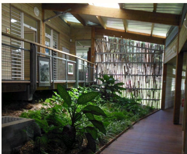
Bardage ajouré en bois local non traité, Parc National - Guadeloupe - Architectes : Atelier 13, Acapa, photo : EQUINOXE
