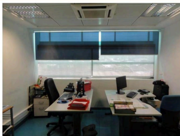
Exemple d'opacification d'allèges vitrées – Bâtiment ARS Guadeloupe – avant / après
