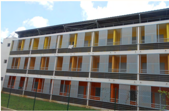
Volets coulissants en tôle perforée Internat, lycée de Baimbridge - Guadeloupe - Architectes : DORE-MARTON, photo : EQUINOXE
