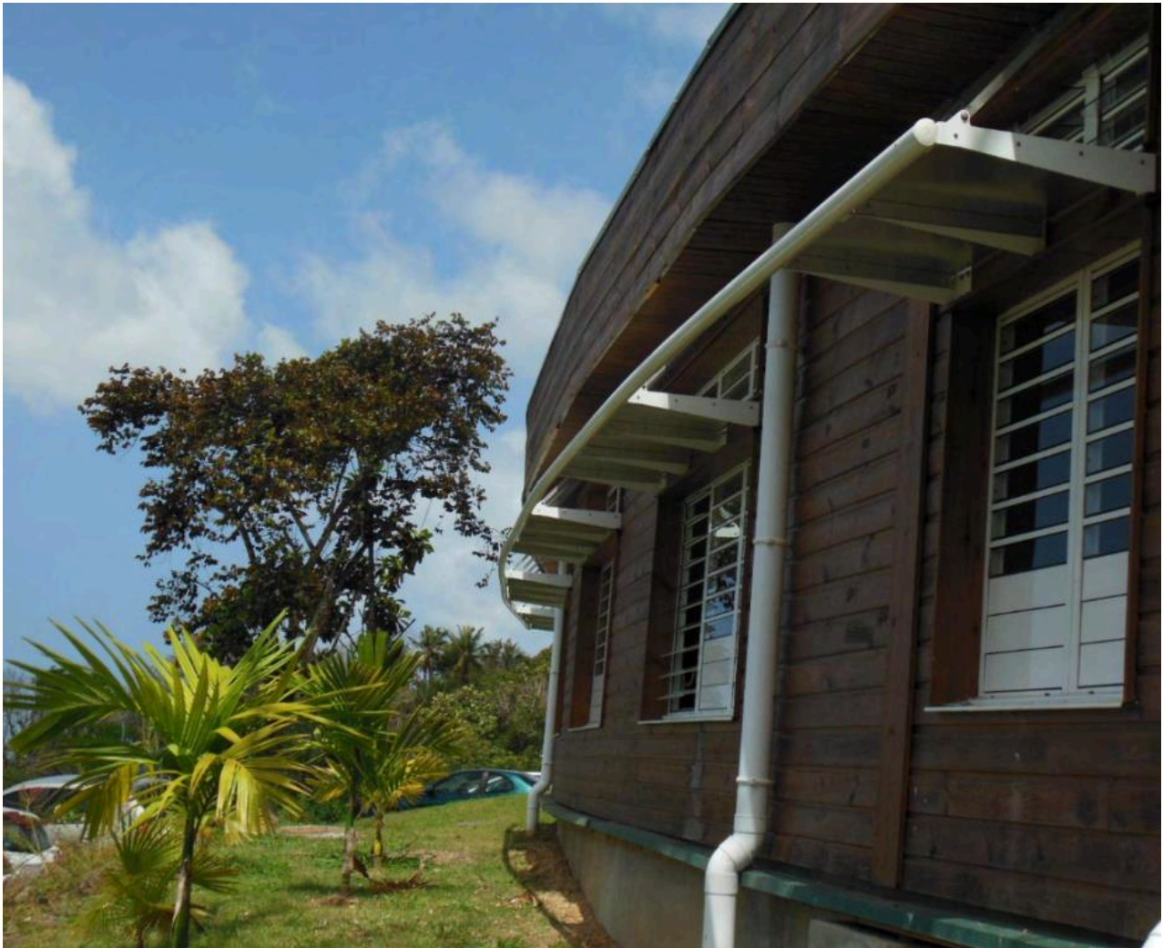
Parc National de Guadeloupe, St-Claude – Guadeloupe - Architectes Atelier 13 et ACAPA
