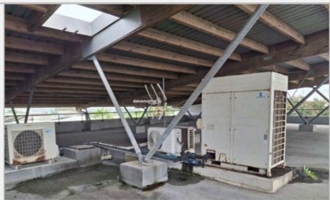
Surtoiture en tôle, charpente bois et poutres en métal
