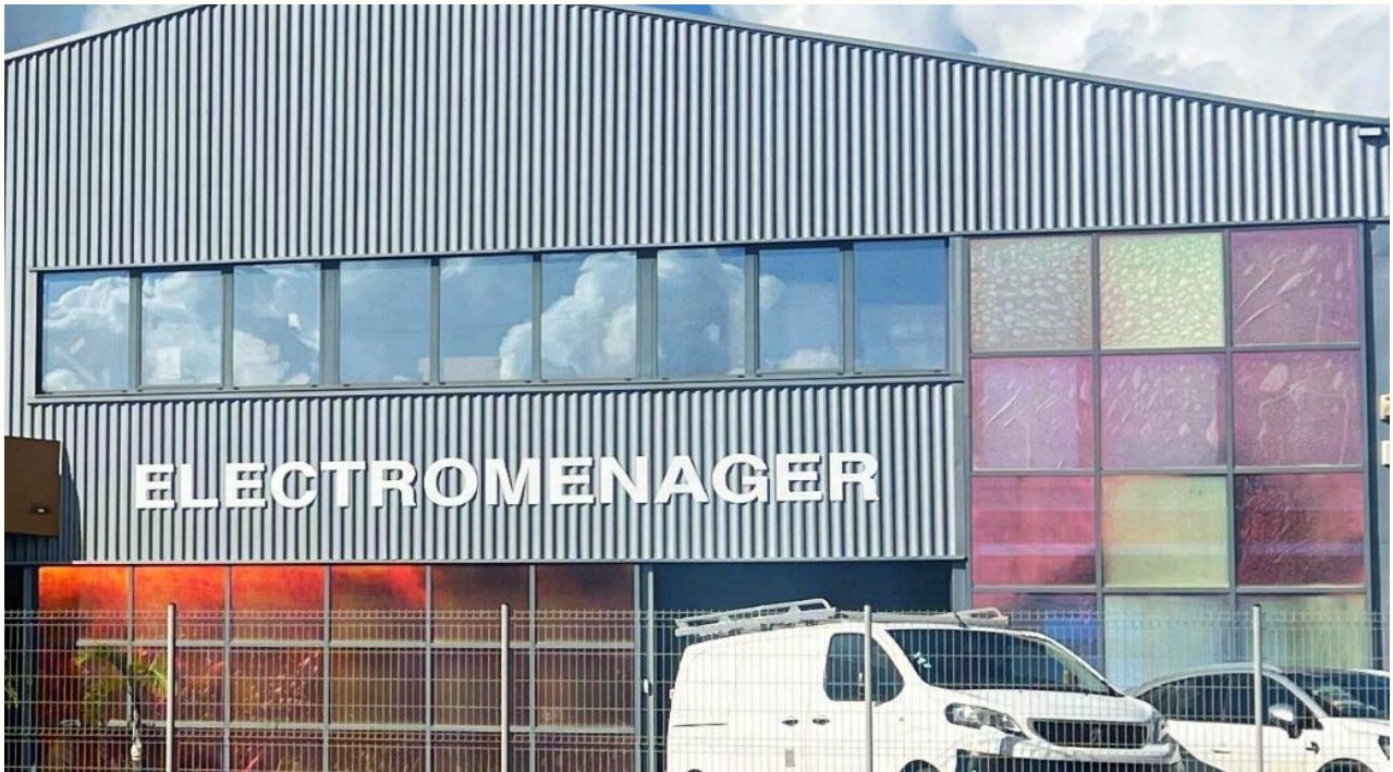
Vieillesse prématurée de films solaires – Immeuble commercial ZAC de Moudong - Guadeloupe - photo : ÉQUINOXE
