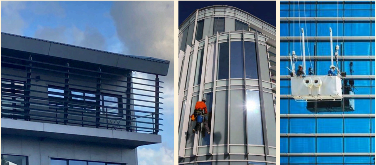
Les coursives assurent un accès facilitant l'entretien des façades.
