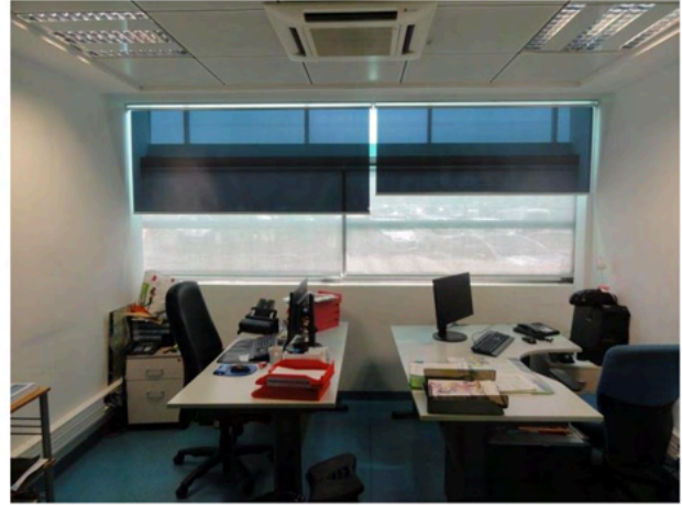
Bâtiment GPG-ARS Guadeloupe : protections solaires intérieures mises en œuvre (opacification des allèges, stores intérieurs)
