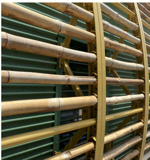
Brise-soleil en bambou sur structure métallique, Office de Tourisme - Mayotte - Architecte : Tand'M architectes, photo : Tand'M architectes
