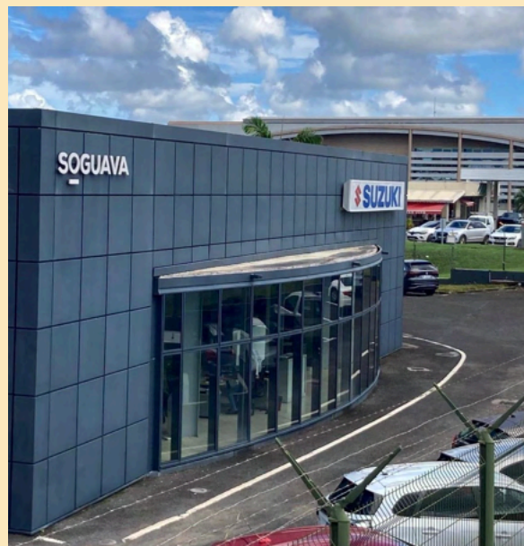
Concession automobile à Moudong - Baie-Mahault (Guadeloupe)
