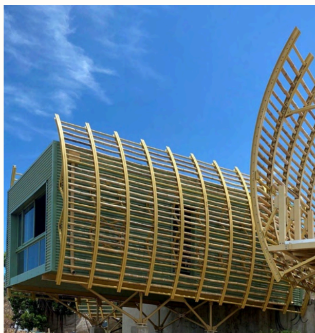
Brise-soleil en bambou sur structure métallique, Office de Tourisme - Mayotte - Architecte : Tand'M architectes, photo : Tand'M architectes
