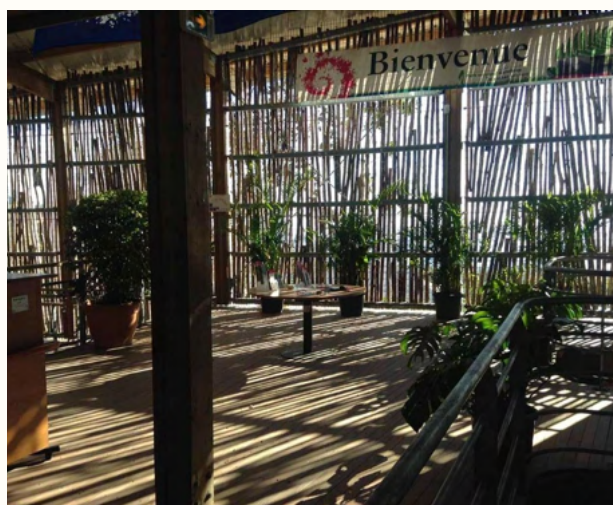
Bardage ajouré en bois local non traité, Parc National - Guadeloupe - Architectes : Atelier 13, Acapa, photo : EQUINOXE
