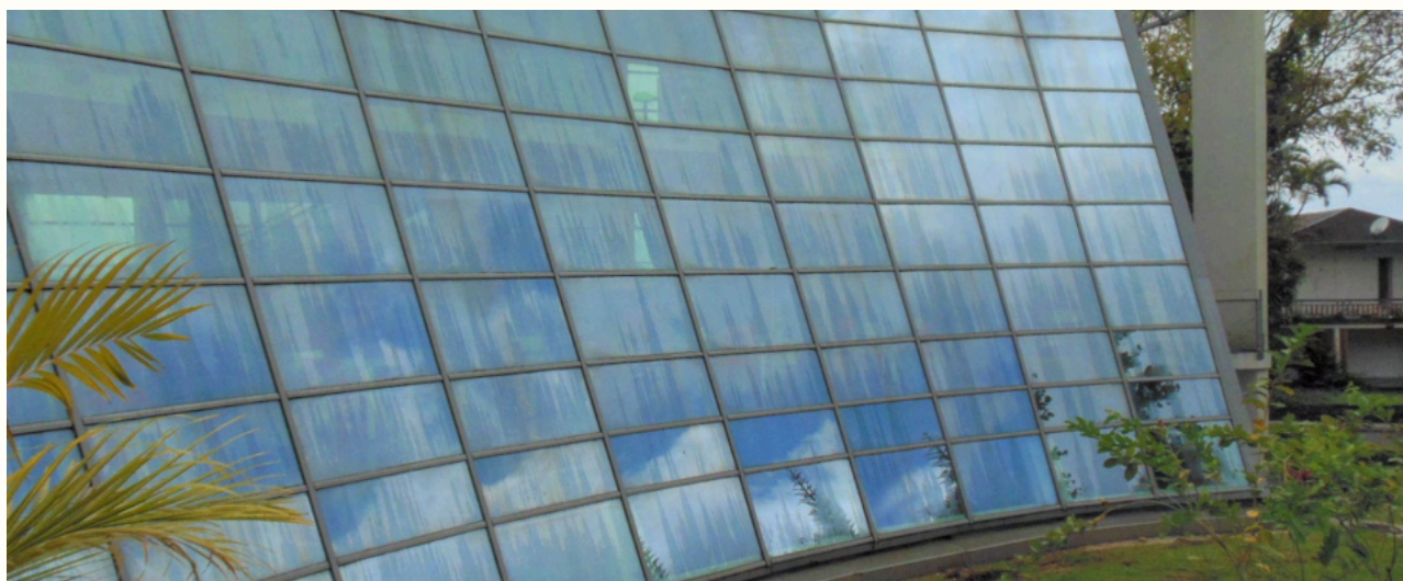
Mur rideau vitré, médiathèque Saint Claude - Guadeloupe - Architecte Alain Nicolas
