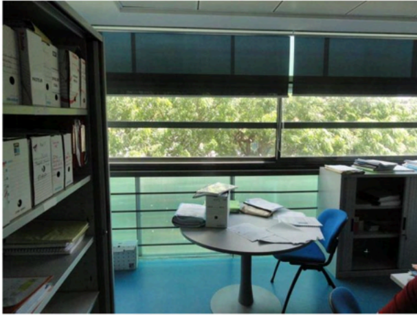
Bâtiment GPG-ARS Guadeloupe : protections solaires intérieures mises en œuvre (opacification des allèges, stores intérieurs)
