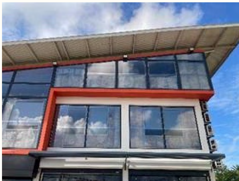
Doublages intérieurs sur un bâtiment tertiaire – Rémire-Montjoly (Guyane)
