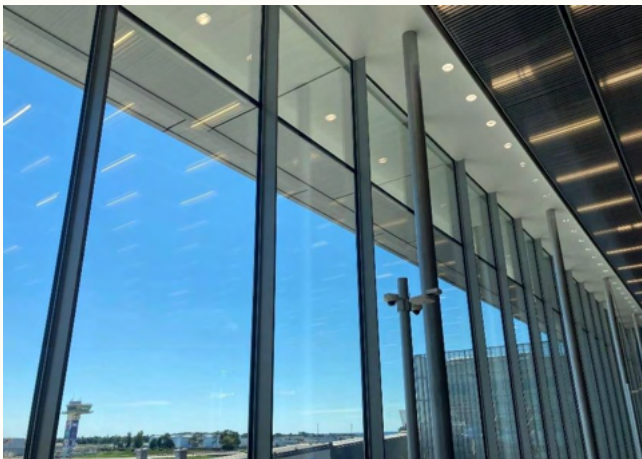
Protection solaire d'un mur vitré de hall d'aéroport - Paris Orly -
