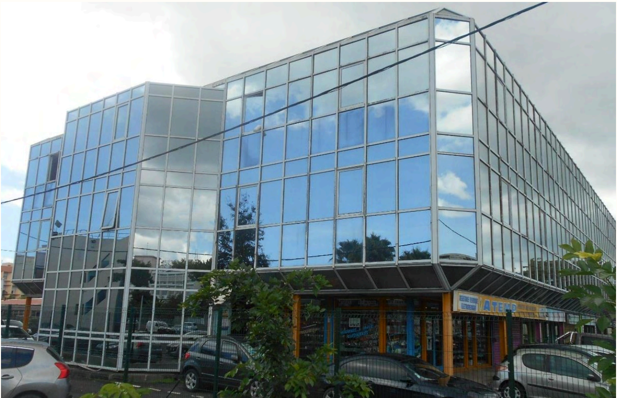
Centre d'affaires « Bergevin » entièrement vitré à Pointe-à-Pitre - Guadeloupe -
