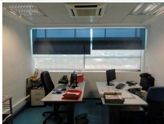
Bureau avec allège translucide (gauche) et protégé par une paroi isolée en allège (droite)
