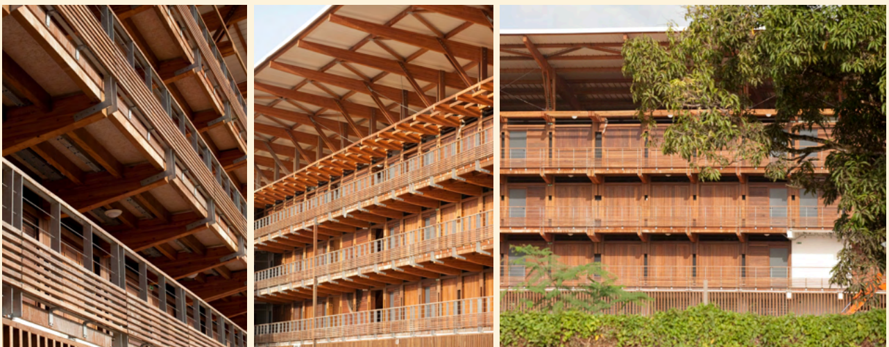
IUFM Guyane : les brises soleils servent eux-mêmes de coursive, architecte : ACAPA Architecture, photo : Robert Célaire
