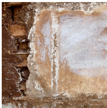
ENDUIT APRES TEST
