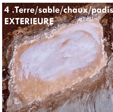
ENDUIT AVANT TEST
