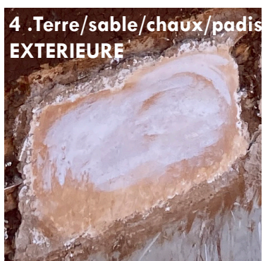
ENDUIT AVANT TEST
