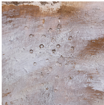
ENDUIT APRES TEST
