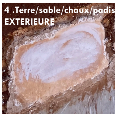
ENDUIT AVANT TEST
