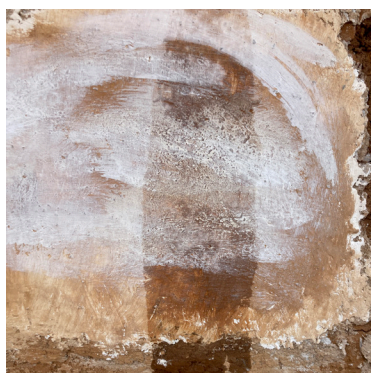
ENDUIT APRES TEST
