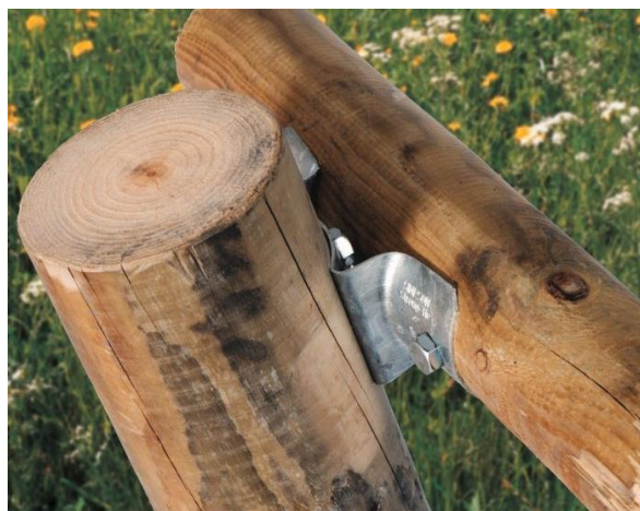
Ou par boulonnage et connecteurs métalliques
